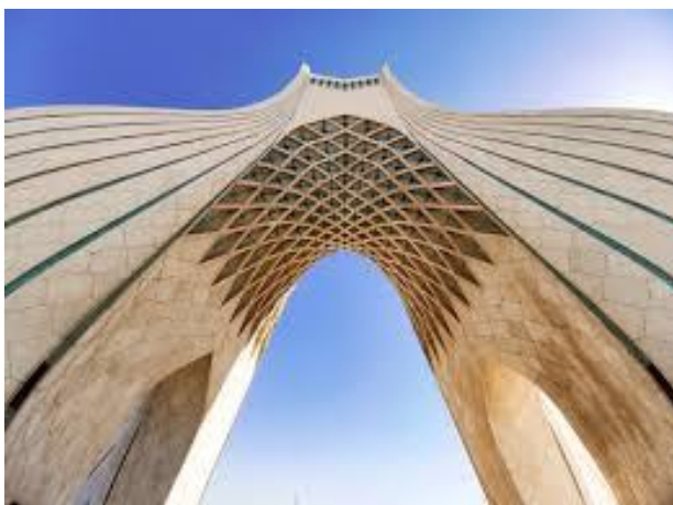
شکل ۲۶- قواره‌بندی پوشش سنگی برج آزادی
